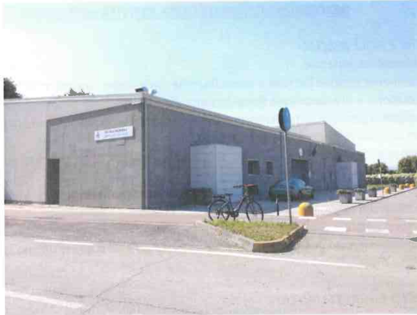
“Leonardo da Vinci” Corpo staccato di nuova costruzione – Via Treviglio
